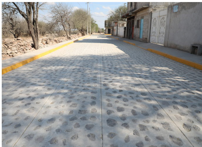
Construcción de la calle que conduce a la planta de tratamiento en Ajuchitlán. Monto de inversión: 2 millones 462 mil 976 pesos.
