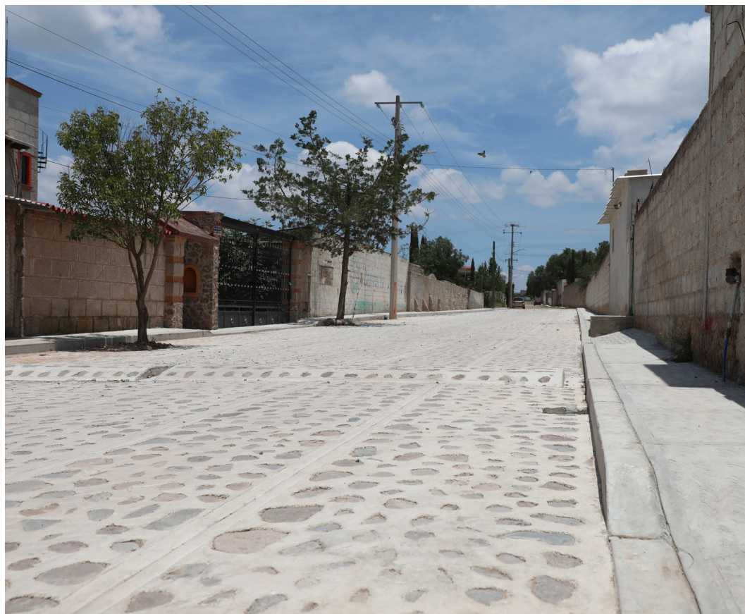
Una obra de infraestructura básica por comunidad
