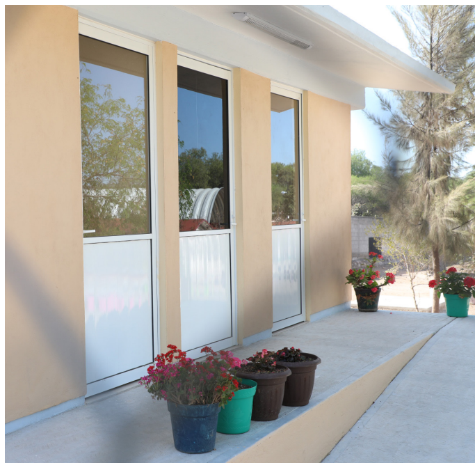
Construcción de baños en el preescolar de la comunidad de Ajuchitlán. Monto de inversión: 1 millón 093 mil 404 pesos.
