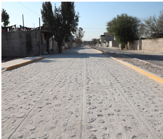
Urbanización de calle Corregidora y Lázaro Cárdenas en la comunidad de El Blanco. Monto de inversión: 3 millones 961 mil 223 pesos.
